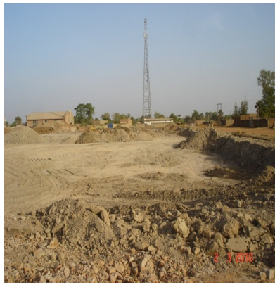
Projet PADUR site rétention bassin 2
