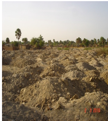
Dépôt terre bassin 2
