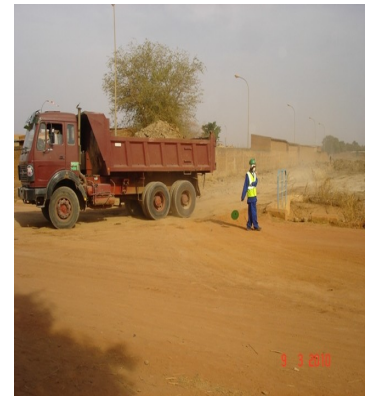
Projet PADUR site rétention bassin 3
