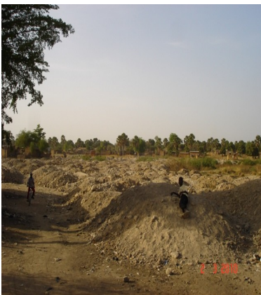
Dépôt terre bassin 1
