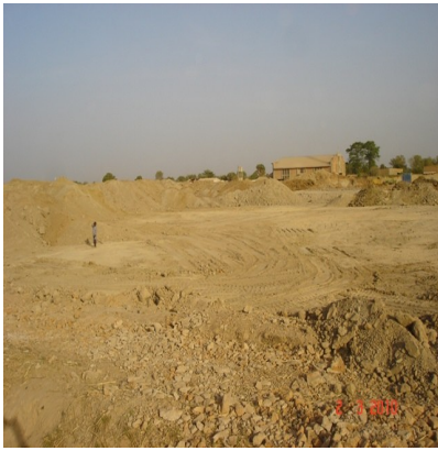
Projet PADUR site rétention bassin 1
